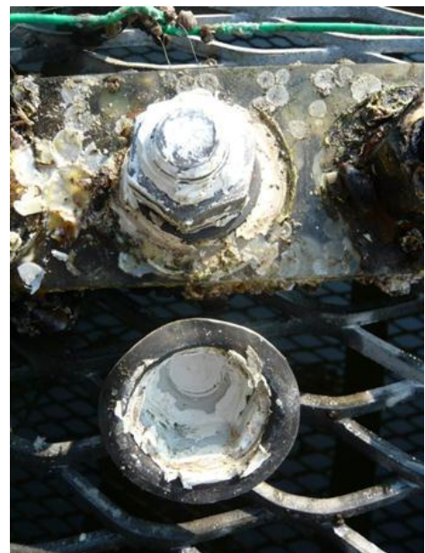
写真. 防錆キャップと内部ボルトの状況（左：亜熱帯 10 年暴露後、右：干満帯 4 年暴露後）
