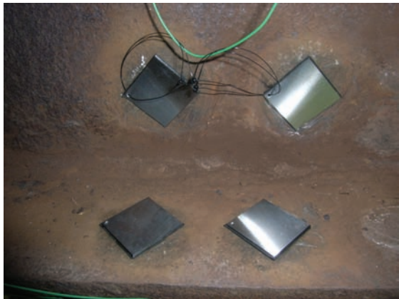
写真-2 A橋のウェブと下フランジ上面の試験片
