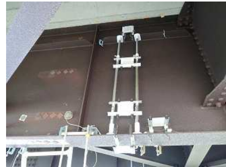
写真-1 計測器具取り付け状況
