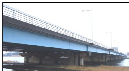
写真 1 弁天大橋外観 (上流側)
