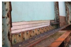
写真-1.1 腹板切削状況
