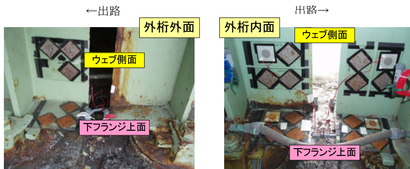
図2 モニタリング鋼板とACM腐食センサの設置状況
