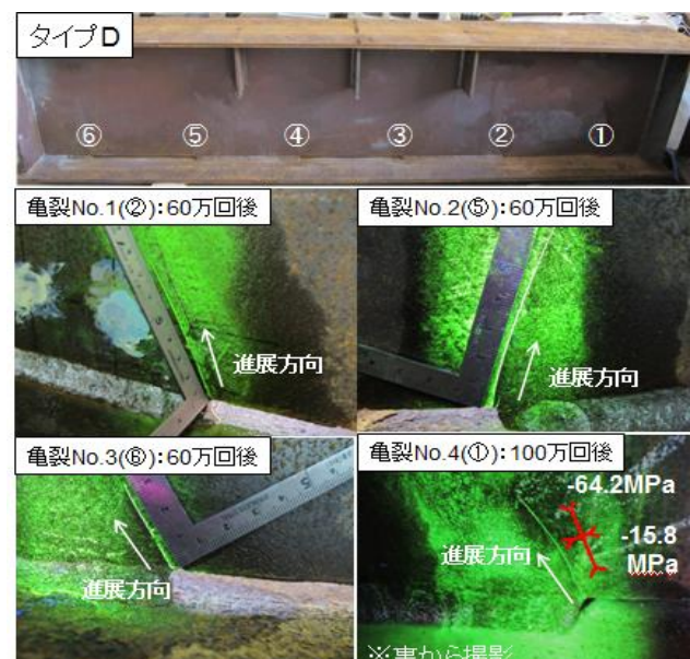
写真 3 亀裂発生例(タイプ D)
