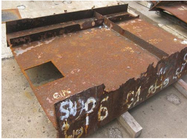
写真 1 実腐食部材使用部材
