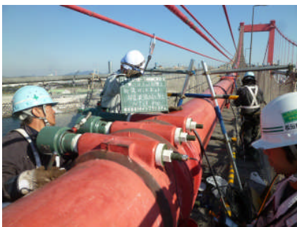
写真④. バンドボルト取替
