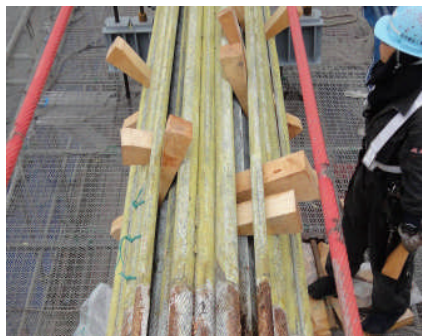
写真①. 主ケーブル調査状況
