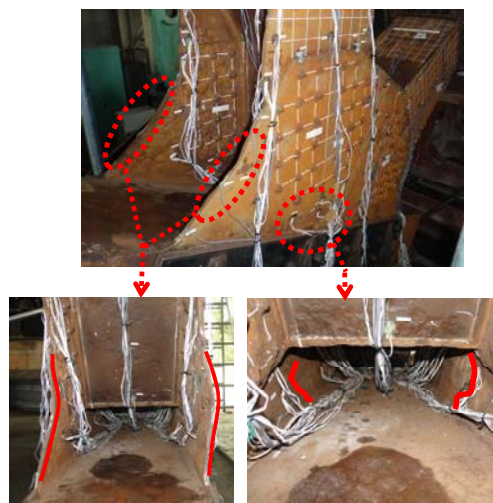
図-6 試験後の試験体の変形状態
