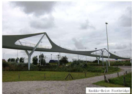
写真-1 橋梁での適用事例(その 1)
