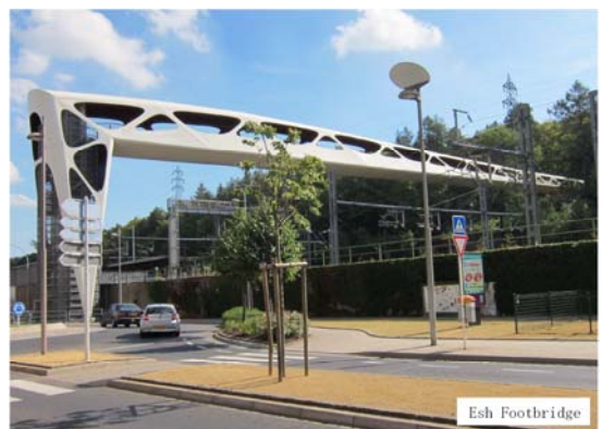
写真-2 橋梁での適用事例(その 2)
