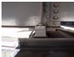
写真-2 応急対策（鋼板挿入）
