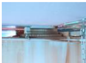
写真-1 シューとソールプレートの隙間
