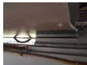
写真-2 応急対策（鋼板挿入）
