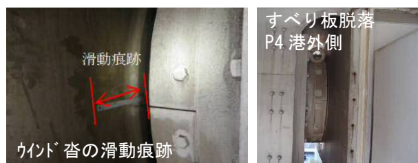
写真－2 ウインド杮の滑動痕跡調査の結果
