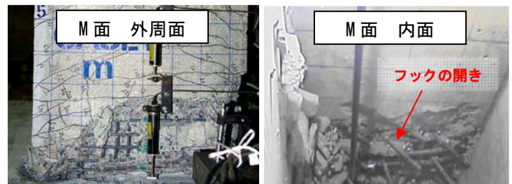
写真1 供試体1の損傷状況 ( 4\delta_0 )
