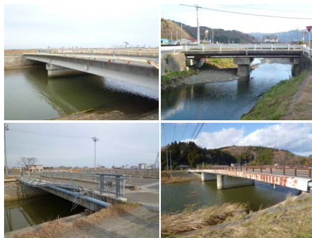
図-4 中小橋梁の被災例
