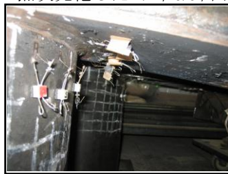
b) せん断遅れ考慮有り試験体
