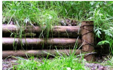
写真-1 道路盛土のり面の木本類 写真-2 丸太筋工の施工状況
