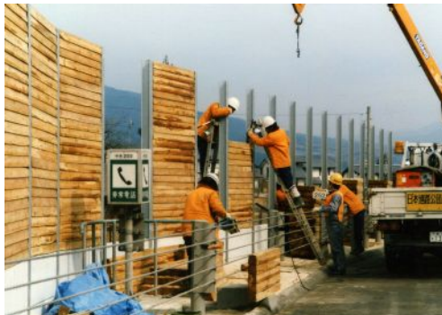
写真1 カラマツ製遮音壁の試験施工
