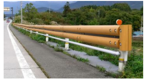
写真2 信州型木製ガードレール1号型
