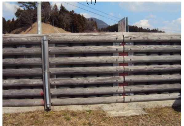
写真-4 サイレントウッディ設置状況 (2)
