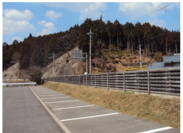
写真-3 サイレントウッディ設置状況 (1)
