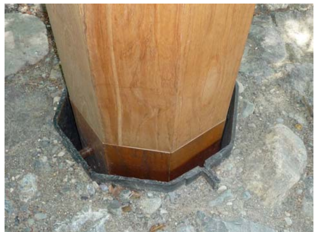
写真 6 橋脚基礎の銅板
