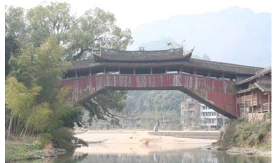
写真-1 北潤橋の外観
