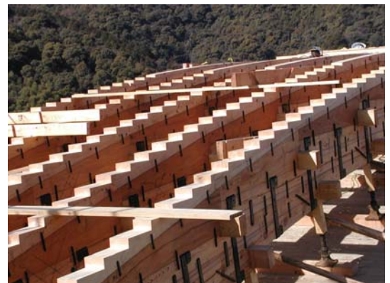
写真-4 錦帯橋の主部材
