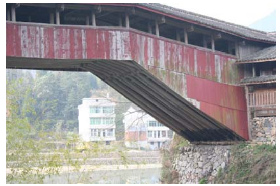
写真-2 北潤橋の主構造の支点部
