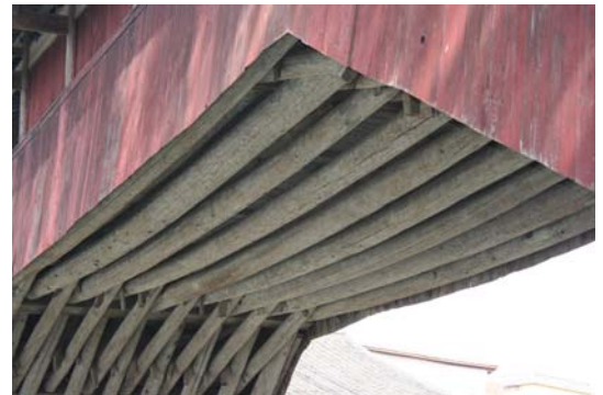
写真-3 北潤橋の主構造の中央部
