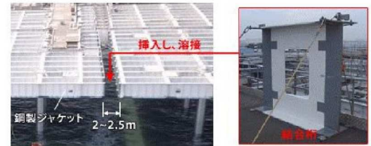
図-7 ジャケットの据付状況
