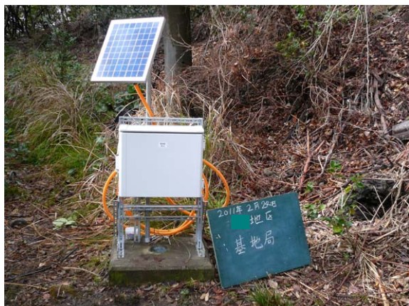
図-5 基地局の設置状況の一例
