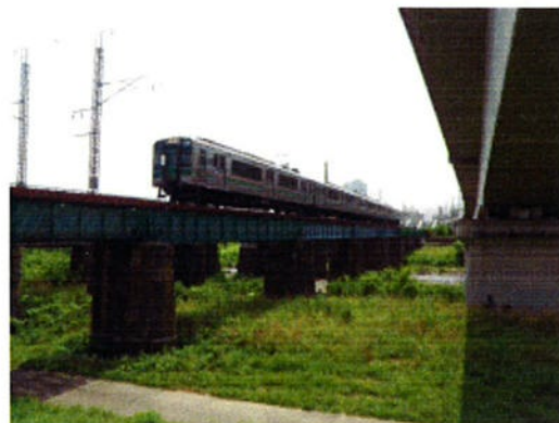
写真-1 測定対象橋りょう
