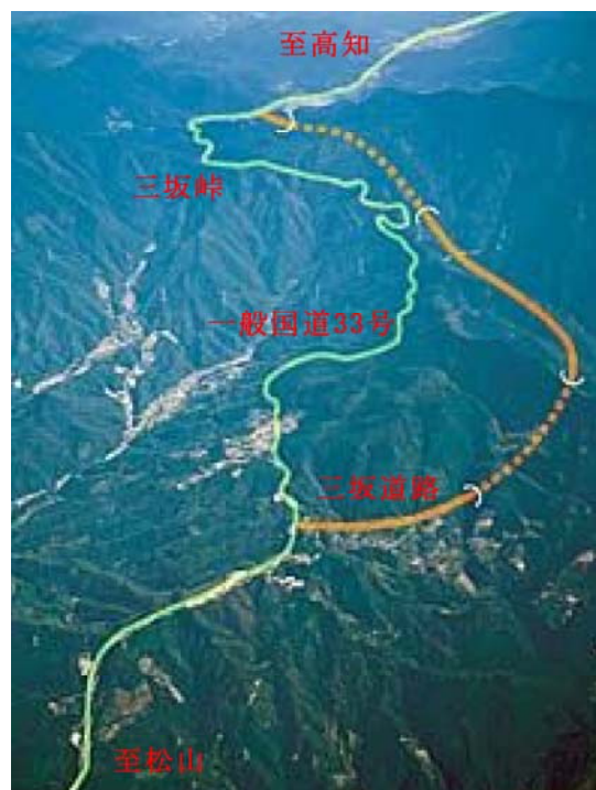
図-2 三坂道路全景
