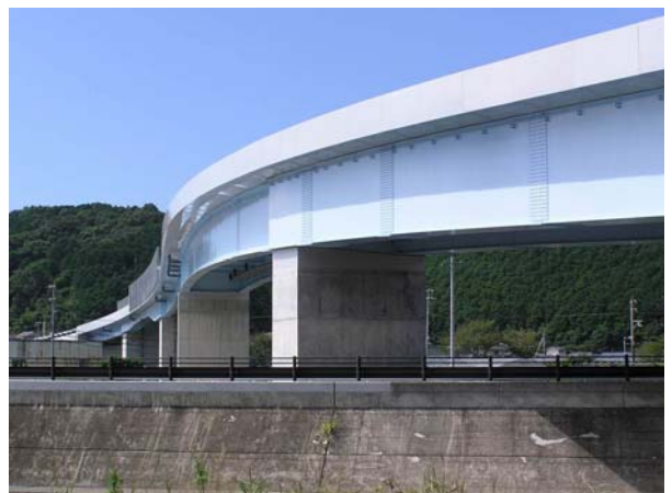
写真 - 1 完成した橋梁
