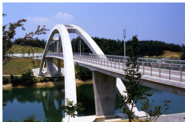
写真-1 光明池大橋(アーチ支間 98m)
