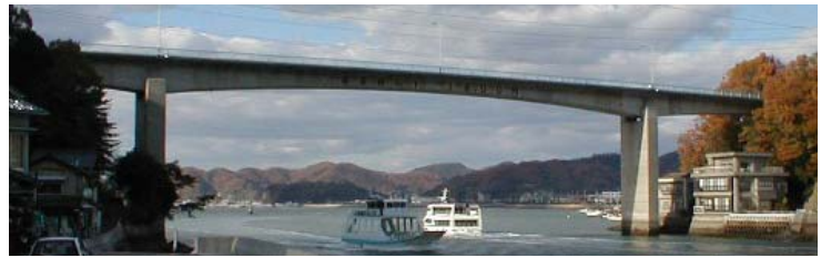
図一七 プレキャストブロック工法で完成した神島大橋
