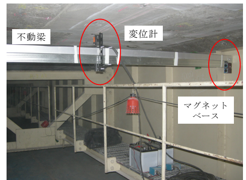
写真-2 たわみ測定状況
