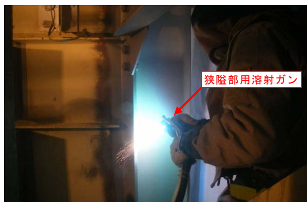
写真-1 鋼桁端部狭隘部への Al-5%Mg 合金溶射
