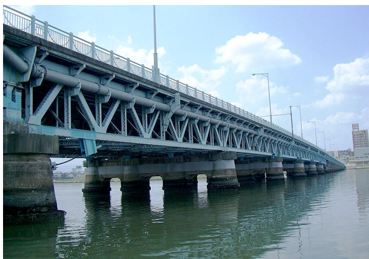
写真 1 対象橋梁外観
