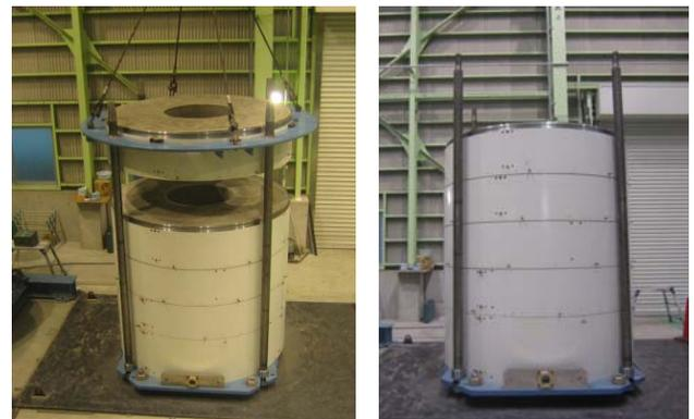
図-6 鋼殻リングPEMの組立状況
