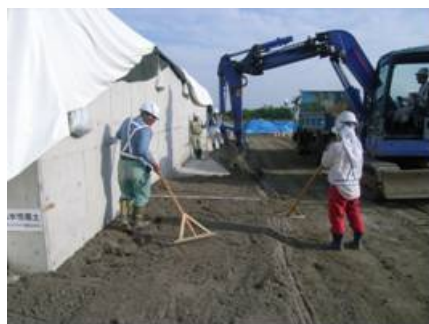
(b)難透水性覆土撒き出し
