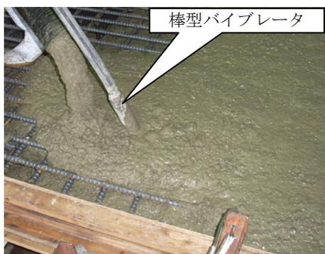
写真-1 供試体へのコンクリート打設状況
