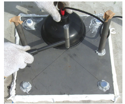
写真-3 補強鋼板の打撃状況
