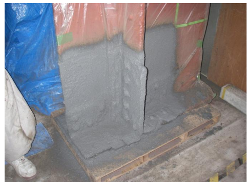
写真 4 ゴムラテックスモルタル被覆施工後の状況
