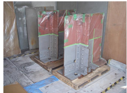
写真 2 ケレン (バキュームブラスト) 後の状況
