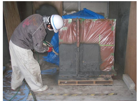
写真 3 ゴムラテックスモルタル被覆施工の状況
