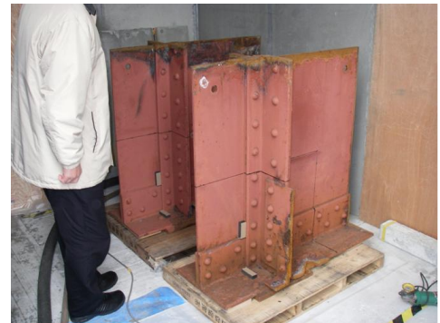
写真 1 支点部供試体の概要 (施工前)
