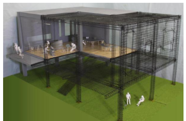
写真-4 建築物配筋模型
