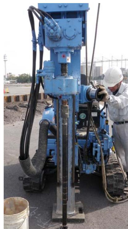
写真-1 打ち込み式井戸の打設状況
