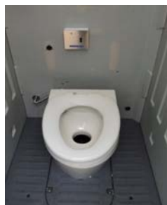
図-3 洗浄水循環型尿分離大便器
