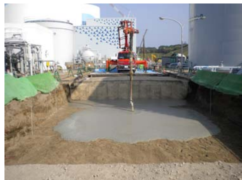
写真-2 浅層混合処理工法
