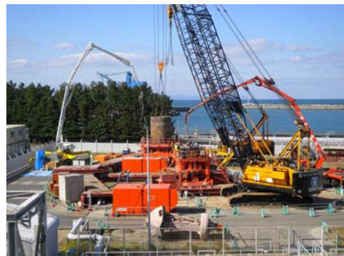
写真-1 置換工法(大口径柱列ソイル工法)
