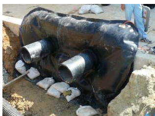
図-2 排水管周りでのインフレート検査状況
