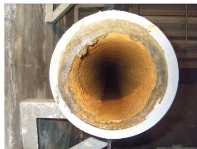
写真2 送水管内部状況
