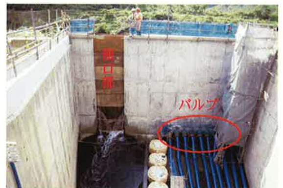
写真-1 仮締切壁全景
