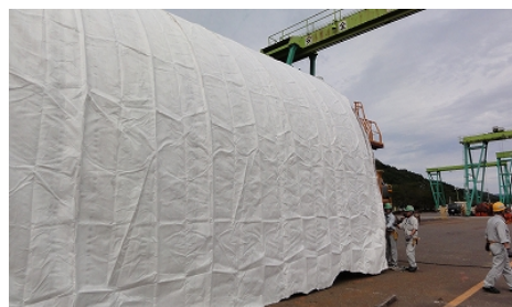
写真-2 展張試験実施後の状況
