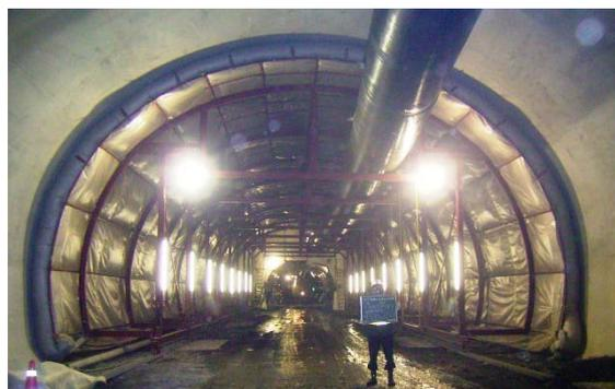
写真-1 養生システム構成図
