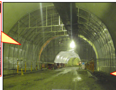
写真-3 移動式覆工コンクリート養生工法
