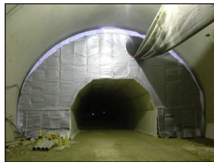
写真-1 セントルバルーン
