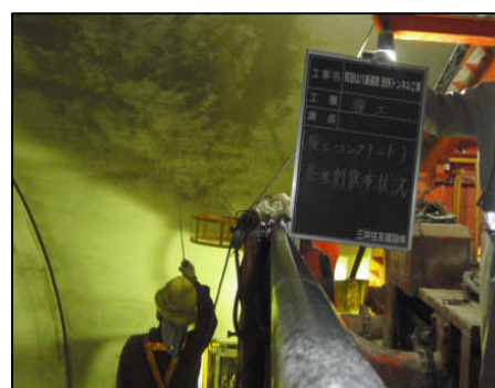
写真-2 高性能収縮低減剤噴霧状況
