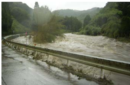
写真-2 大雨時の河川増水状況
