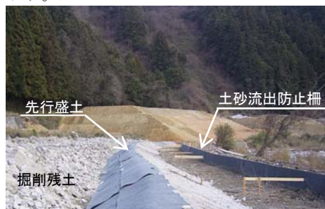
写真-3 残土仮置場の土砂流出防止対策状況
