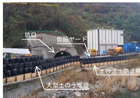
写真-1 仮設ヤード浸水対策状況
