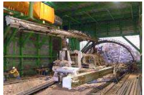
写真2 トレヴィチューブ工法施工状況
