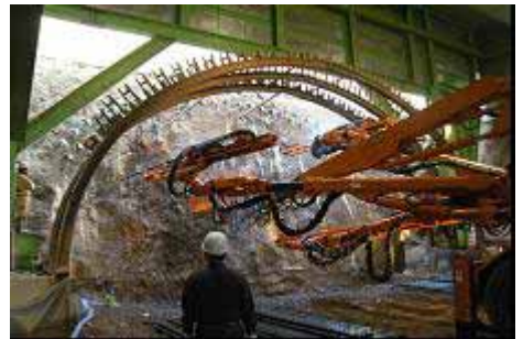
写真3 鏡ボルト工法施工状況
