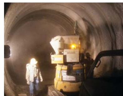
写真-5 吹付け施工状況
