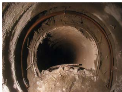
写真-4 支保工建て込み状況
