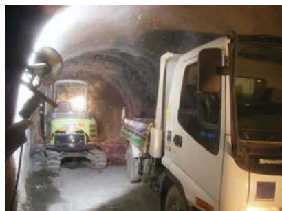
写真-3 掘削・精込み状況
