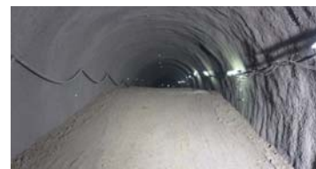
写真-1 押さえ盛土完了全景
