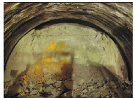
写真-1 試験工事の切羽状況
