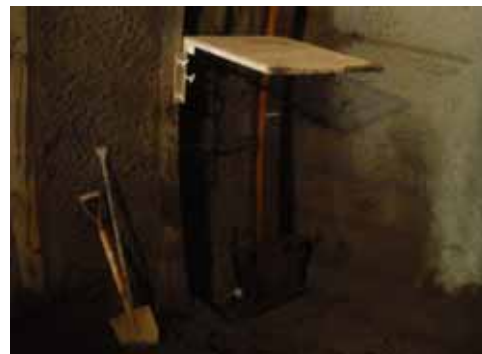
写真-2 脚部補強支保工の設置状況
