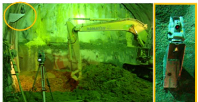
図5 現場適用試験におけるトータルステーション設置状況
